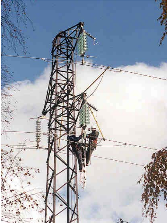
Figure 2 : L'image de gauche représente une équipe de RTE installant des parafoudres à intervalle d'air sur une ligne à 90 kV, celle de droite une équipe de KELAG (Autriche) installant des parafoudres sur une ligne 110 kV
