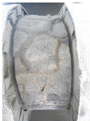
Figure 26 – Etat de la surface du verre cellulaire au niveau de la tranche C après l'essai jet fire.
