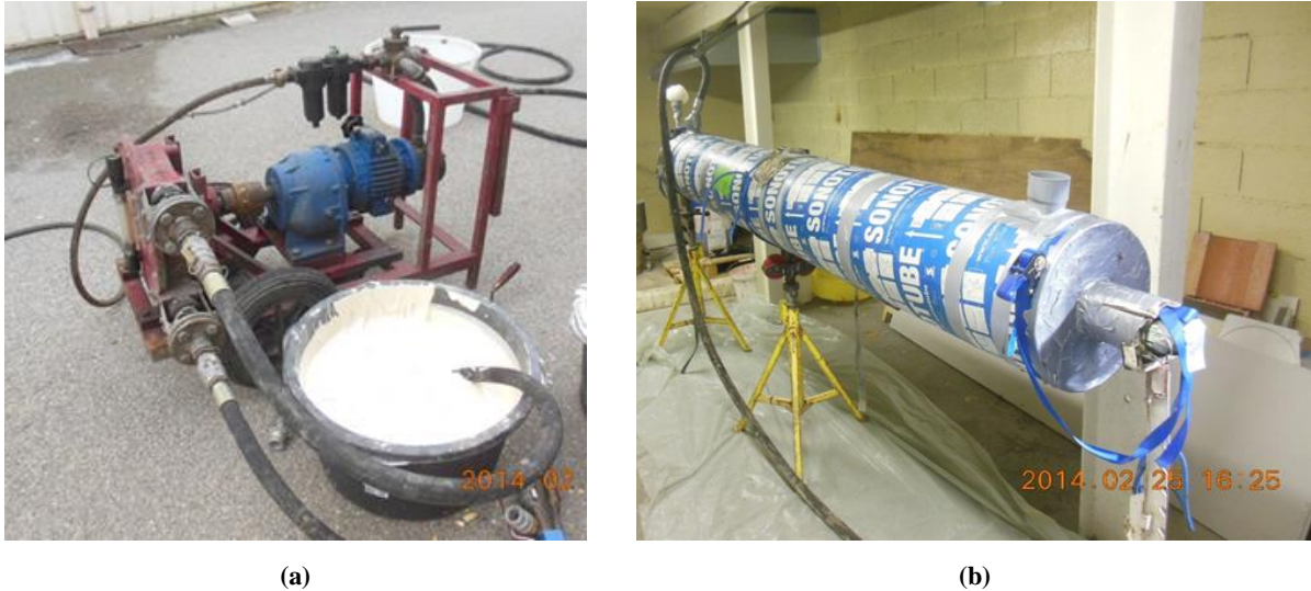
Figure 37 – Pompage (a), transfert et injection (b) du mélange de mousse syntactique phénolique.
