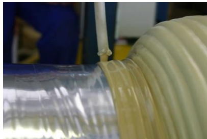
Figure 28 – Application en coulée et expansion de la mousse PIR (Image Prezioso Linjebygg).
