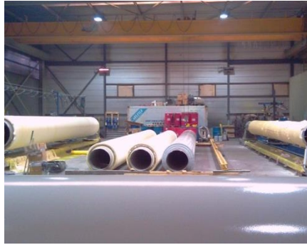
Figure 15 – Atelier dédié à la pré-isolation de lignes de GNL (Gaz Naturel Liquéfié) à base de mousse de polyuréthane (Image Prezioso Linjebygg).
