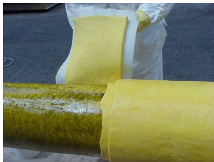
Figure 30 – Application manuelle de la mousse syntactique phénolique [45].
