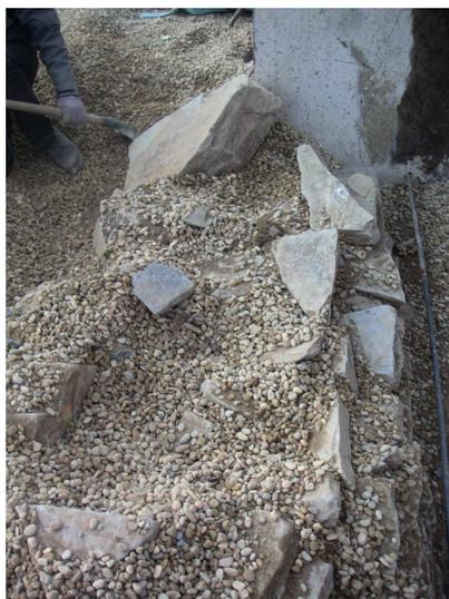
Figure 3.28 – Blocs restés en place après la chute du mur C2s (parement interne à droite).
