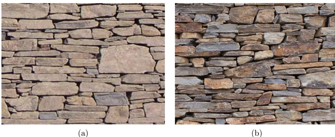
Figure 3.5 – Différences de parement entre un mur en schiste « ingénieur » (a) et un mur en schiste « paysan » (b).
