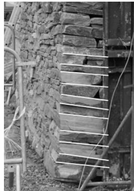
Figure 3.40 – Redressement progressif de l'inclinaison des assises du mur C3s de 9 à 4°.
