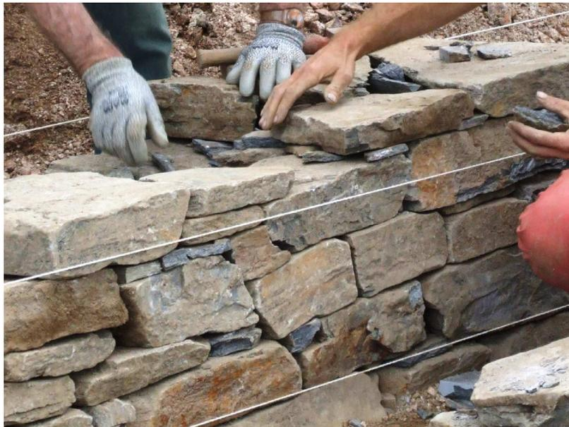
Figure 1.1 – La maçonnerie à pierres sèches.
